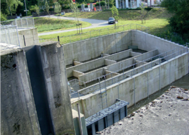
Einstieg in die Fischtreppe Nassau
