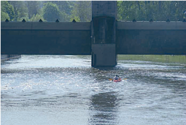
Ein Paddelboot fährt unter der hochgezogenen Wehrklappe durch. Das Wasser ist aus der Strecke von fast 8 km abgelaufen und damit die meisten Fische nach Rheinland-Pfalz weggeschwommen.
