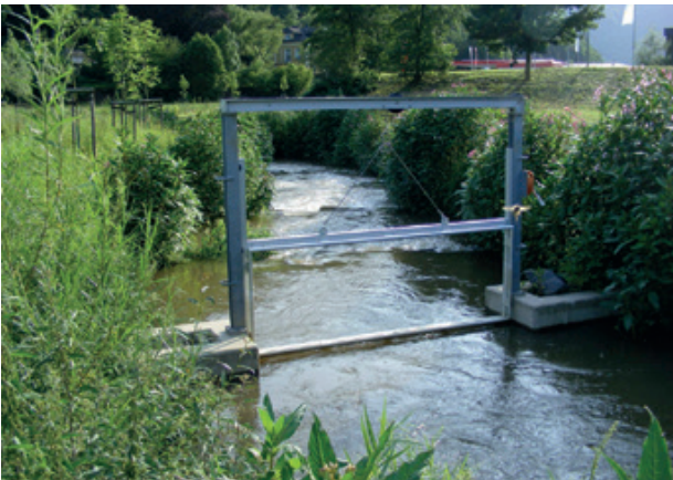
Hier am Ausgang in die Lahn sind die Reusen eingebaut
